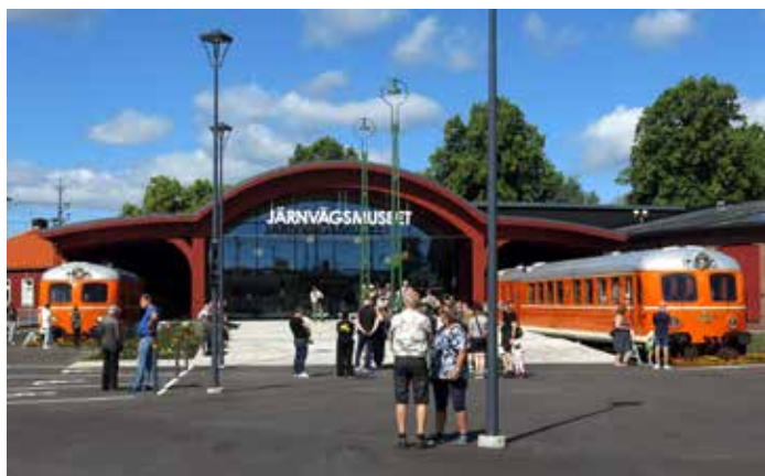
Det nationella järnvägmuseet i Gävle (1) återöppnade sommaren 2024 efter sju års renovering. Foto: Stefan Nilsson.
